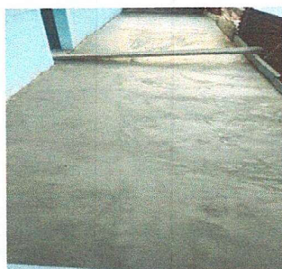
Foto 5: corredor de cocina.
