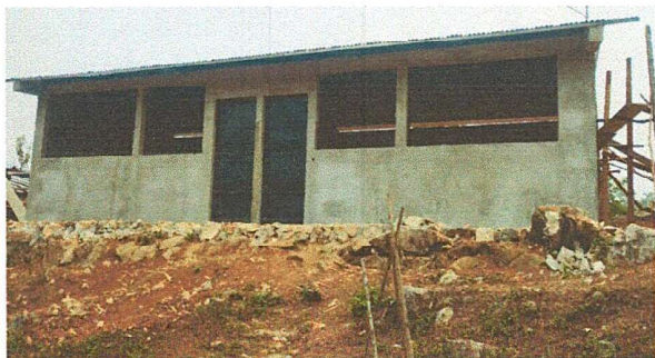
Foto1: escuela de dos aulas
